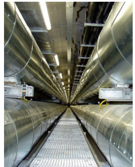
Blick in einen Leitungskanal
