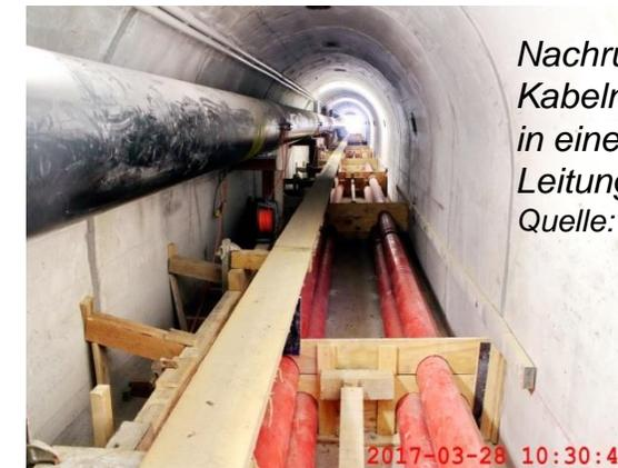
Nachrüstung von 120 kV Kabeln im Sohlbereich in einem betriebenen Leitungskanal
