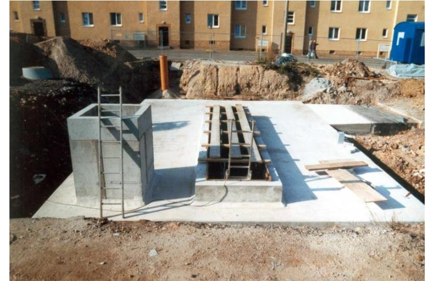
*Kanaleckbauwerk nach Deckenschluss mit Montage-, Ein- und Ausstiegs- sowie Entwässerungsschacht (Quelle: GIBA mbH)*
