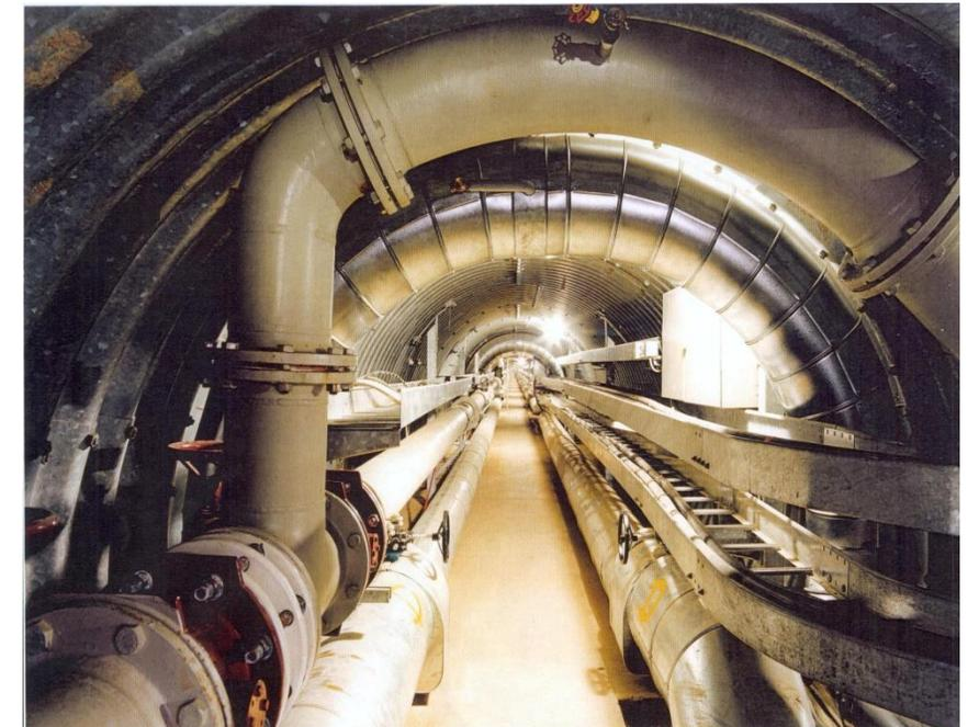
Leitungskanal im Kreisquerschnitt
