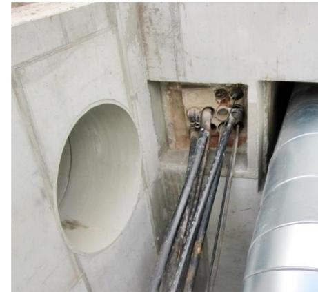
*Innere Vorsatzwand aus wasserundurchlässigen Stahlbeton
