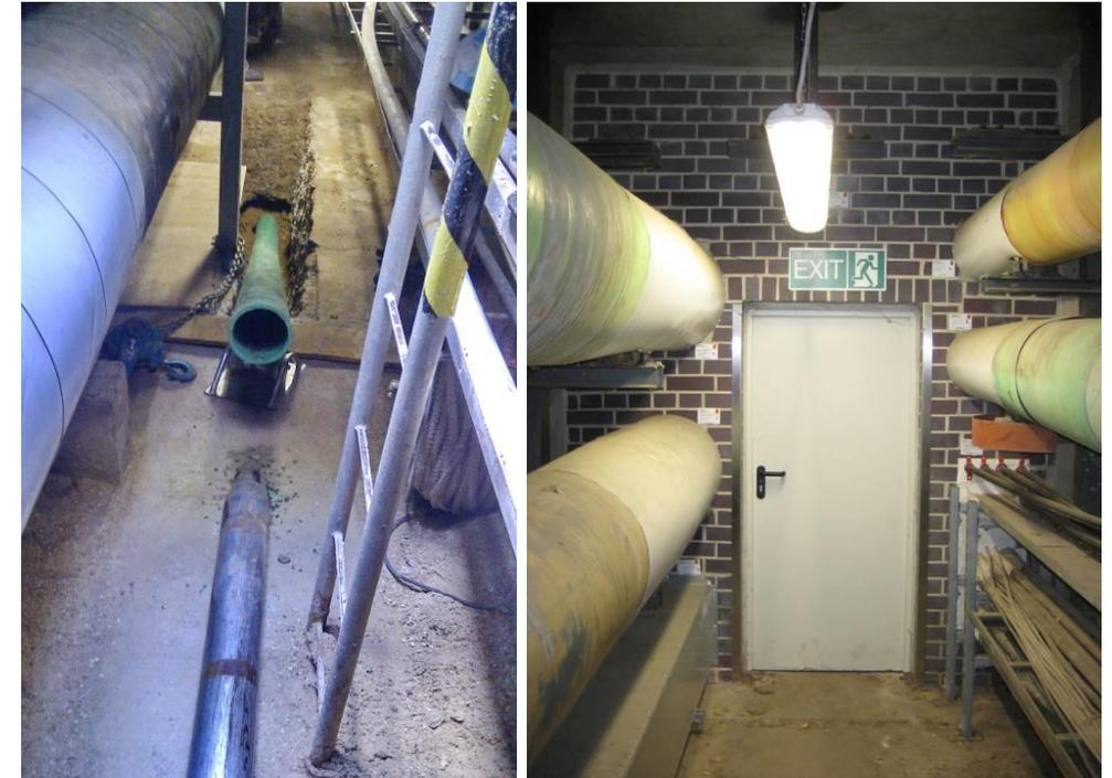
*Beispiele: Erneuerung einer Dränageleitung und nachträglicher Einbau einer Brandwand mit Brandschutztür*
