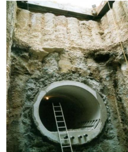
Vortriebsstrecke im Rohbau nach Rückbau der Vortriebstechnik in der Startgrube, späteres Schachtbauwerk
