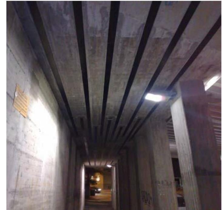
*Verstärkung einer Deckenplatte
