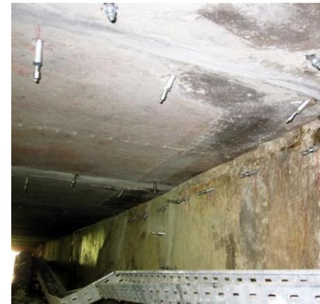
*Nachträgliche Fugenabdichtung von Innen mittels Injektion
