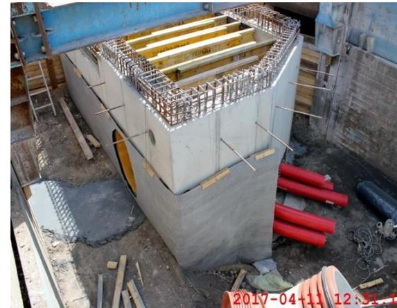
Anpassung der Kubatur im beengten Bauraum am Beispiel eines Kanalendbauwerks
