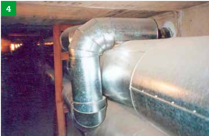
4 Nachträglich eingeordnete abzweigende Heizleitungen
