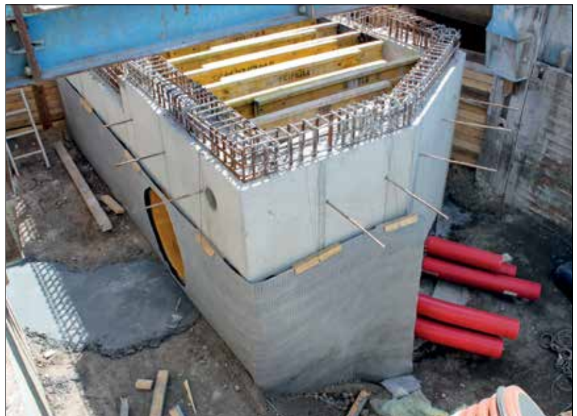
Neubau eines Versorgungschanal-Bauwerks in offener Bauweise
