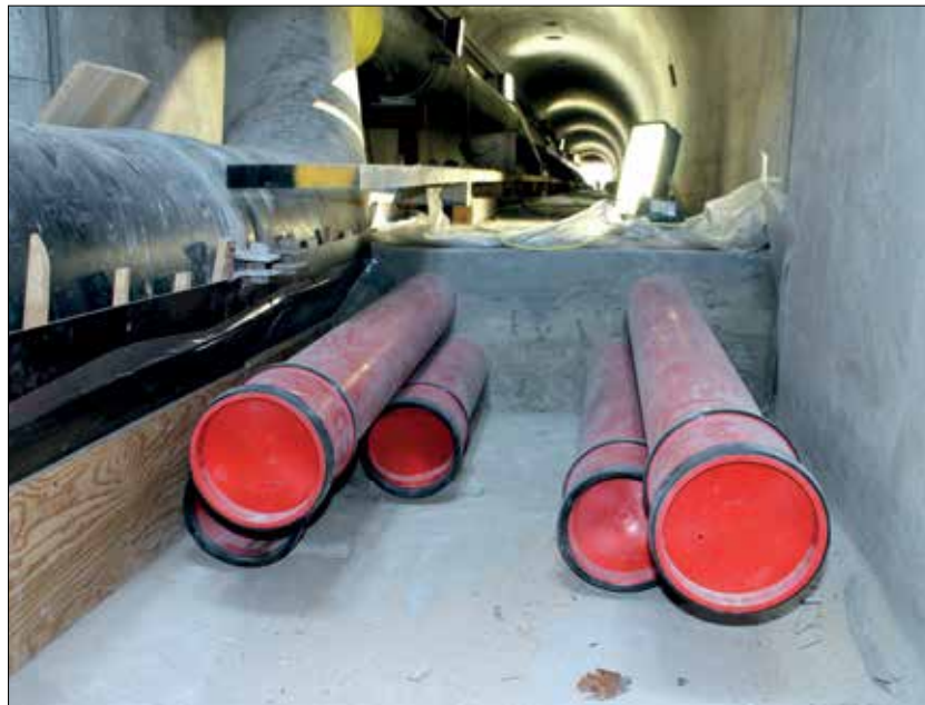
Vorbereitung der Nachrüstung im Leitungsbestand, hier mit Hochspannungskabel
