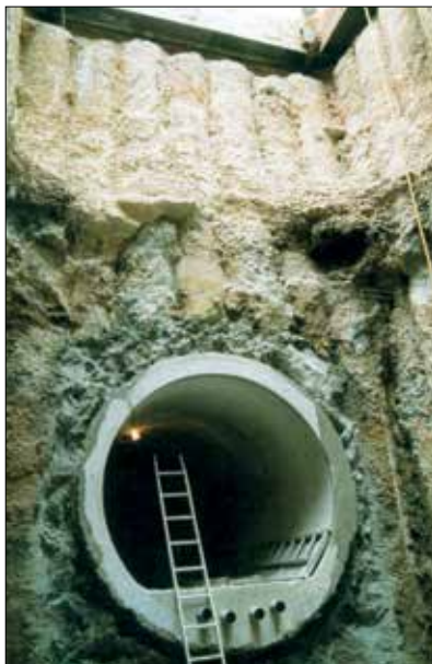
Rohbau eines Versorgungschanals in geschlossener Bauweise
