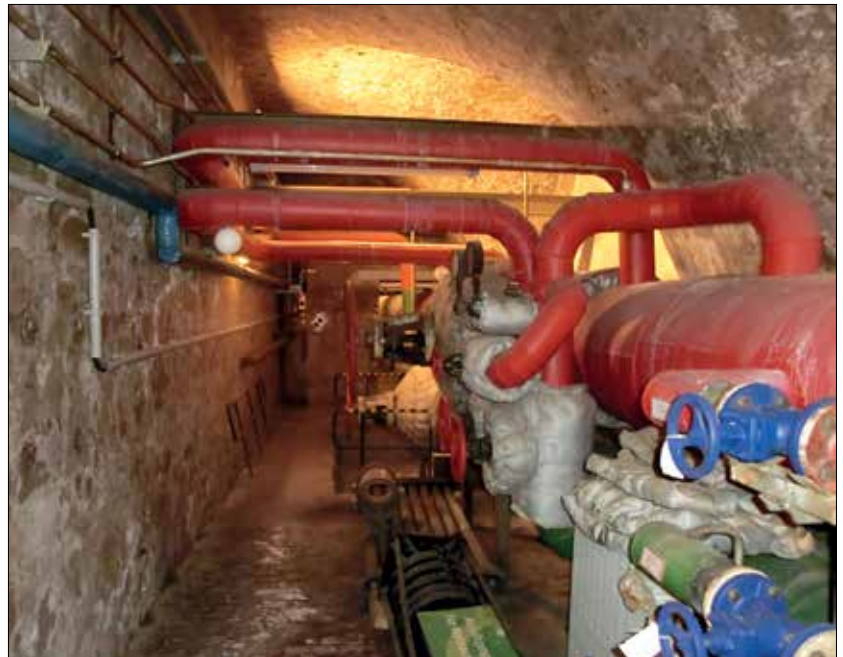
Historischer Fernwärmekanal (Inbetriebnahme 1900): nach wie vor in Betrieb und durch weitere Medien komplettiert
